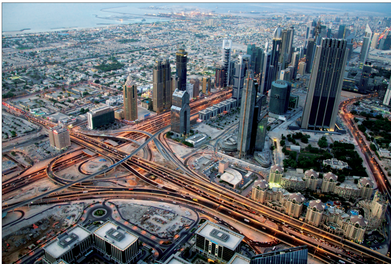
■ SALINI-IMPREGILO ▶ Emirati Arabi Uniti ▶ Dubai Ras Al Khor Crossing
