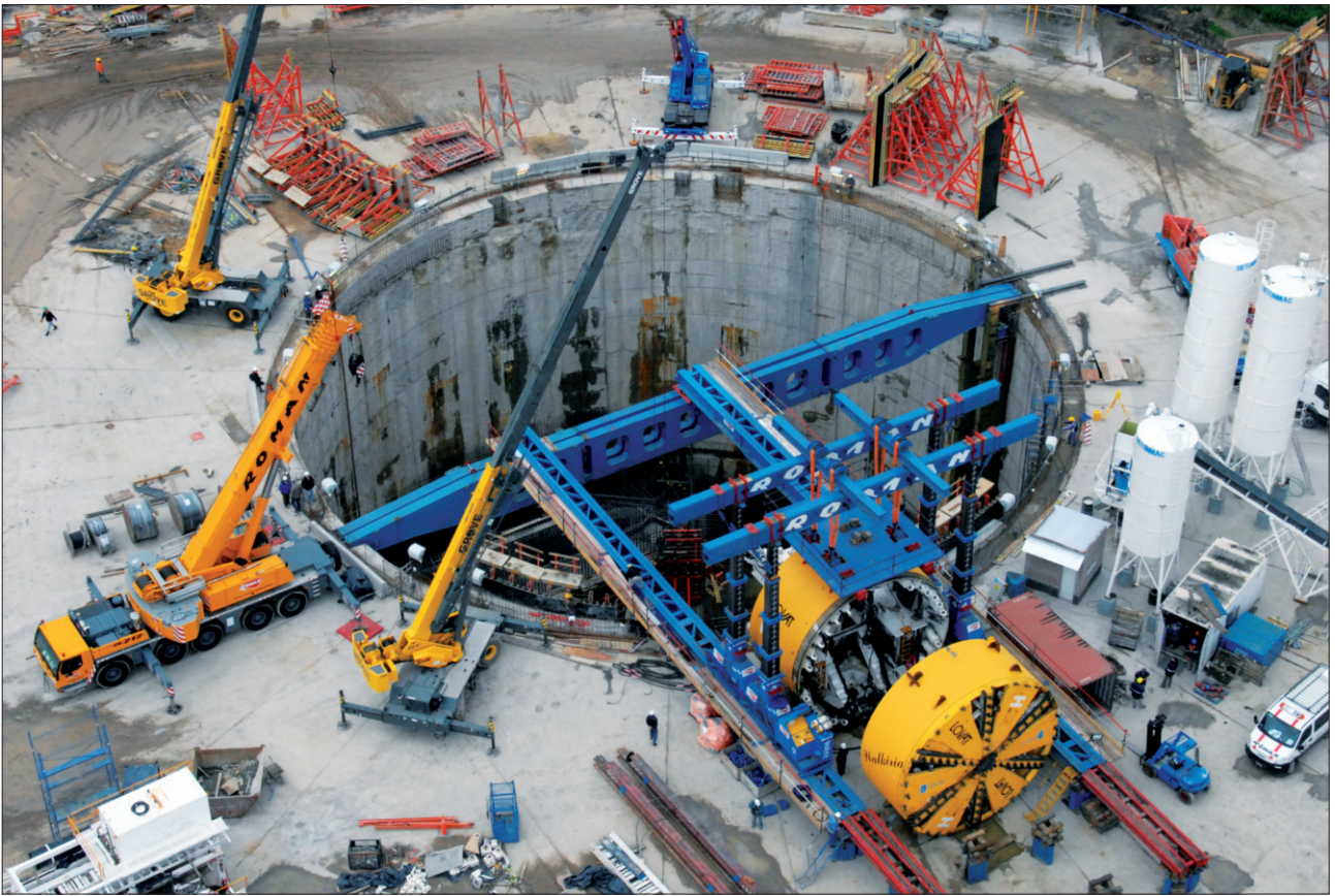
■ GHELLA ▶ Argentina ▶ Opere idrauliche ▶ Tubi di scarico
