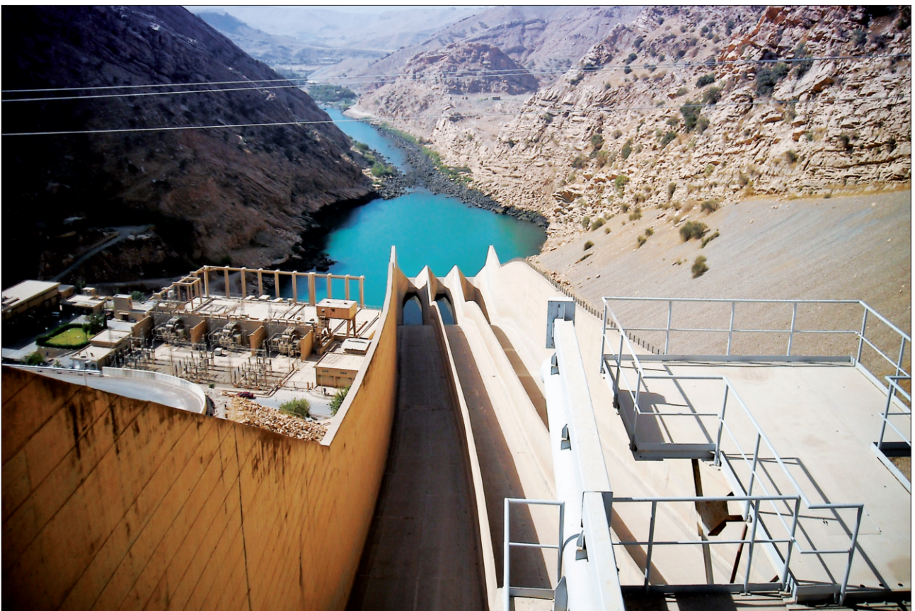
■ BONATTI ▶ Kurdistan, Iraq ▶ Centrale idroelettrica di Derbandikhan
