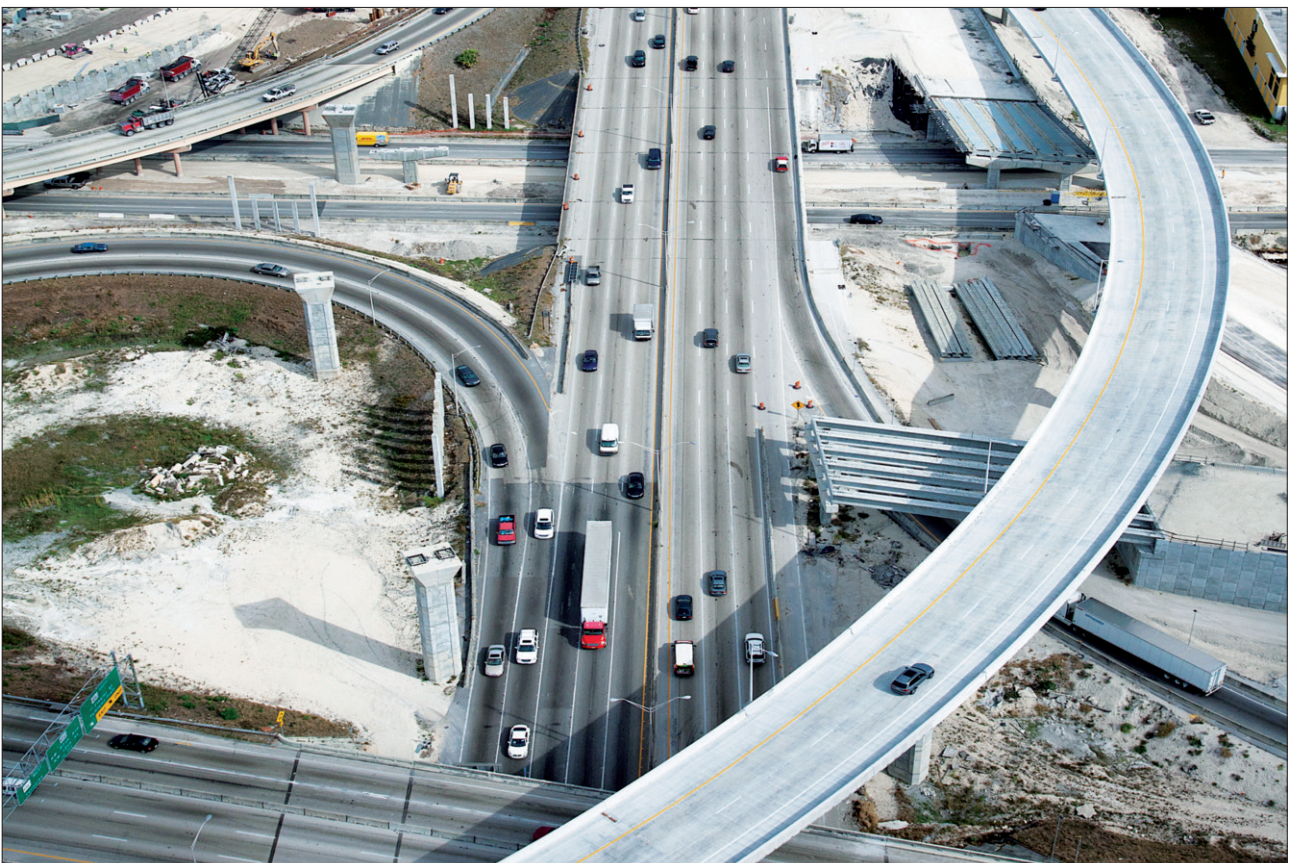
■ CONDOTTE ▶ Florida, USA ▶ Svincolo autostradale
